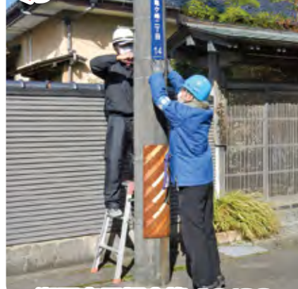
街区表示板交換 10/22
