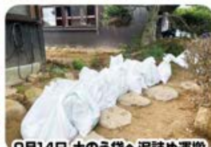
9月14日 土のう袋へ泥詰め運搬
